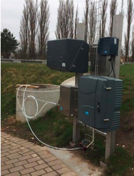
**Fig. 2:** El analizador de TOC BioTector B7000i funciona junto al software Claros RTC-C/N/P para ofrecer un control anticipado de la dosificación de nutrientes.
