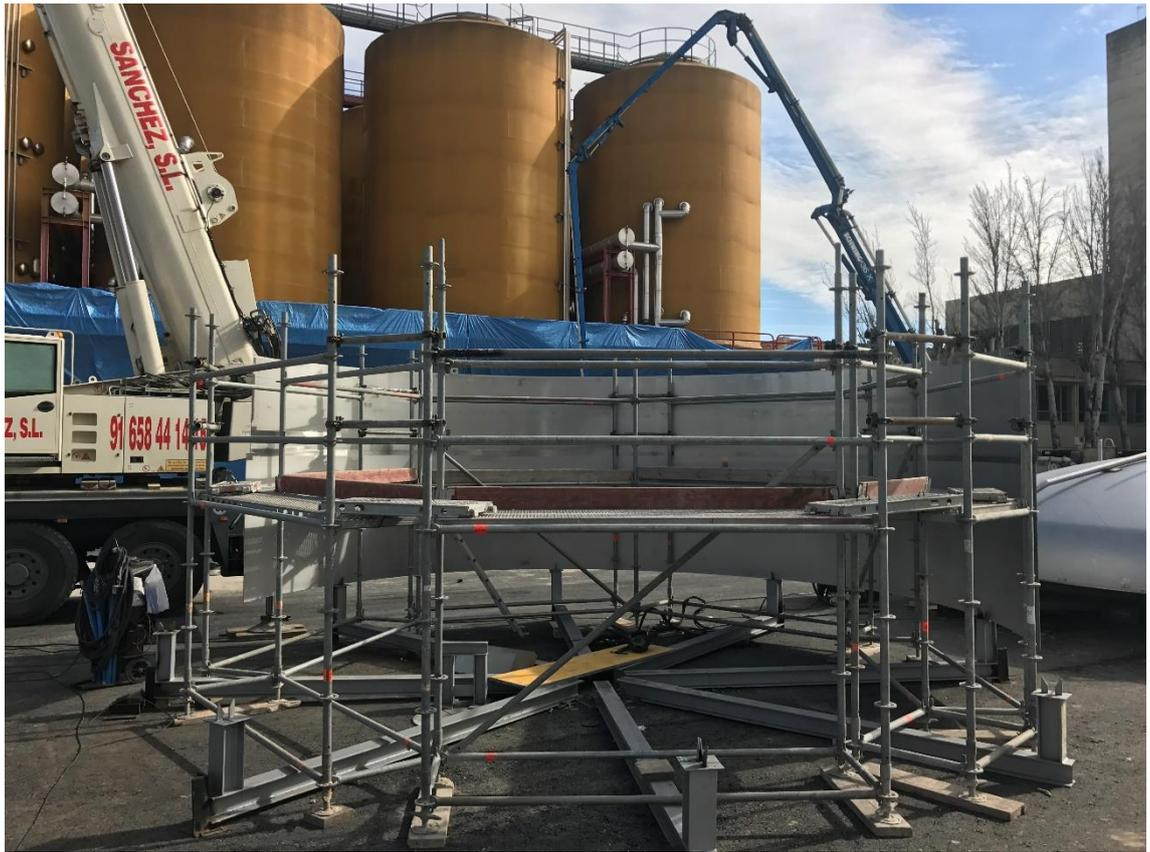
2. Se montan las chapas que formarán el techo sobre la base prefabricada y se sueldan.
