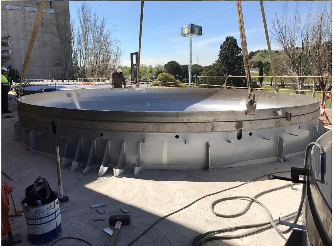
8. Por último se coloca el tanque sobre el fondo cónico y se realiza la última soldadura.
