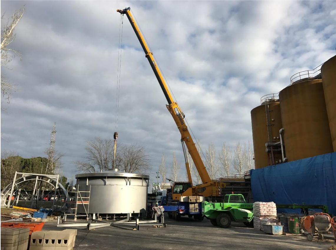
5. Sobre la base prefabricada que nos queda libre, se repite el proceso de fabricación con el resto de virolas.
