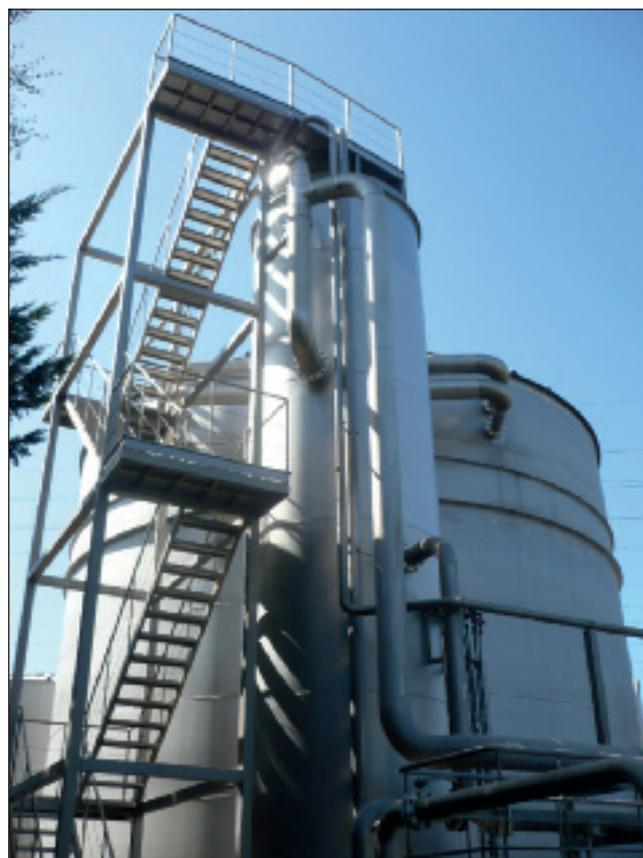
**Figura 2.** Reactor Biobed EGSB en las instalaciones de Unicer en Leça do Balio, Portugal.
